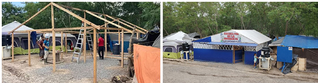
9. Construcción de la “escuelita de la banqueta”.
