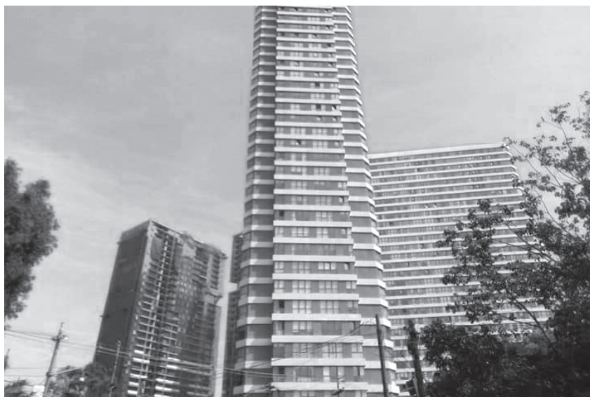
4. Edificación de tipo E. Fotografía: Archivo propio.
