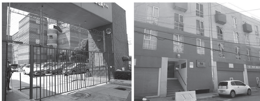
2. Edificaciones de tipo A y B. Fotografías: Archivo propio.
