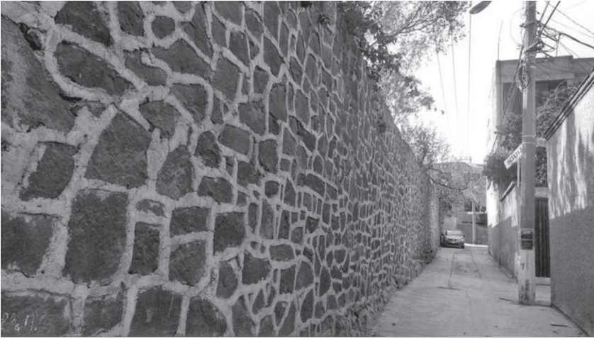
2. Mantenimiento de la barda perimetral que divide una colonia de otra, con financiamiento del Presupuesto Participativo de la Ciudad de México. Fotografía: Resultados de la Consulta Ciudadana sobre Presupuesto Participativo 2017.
