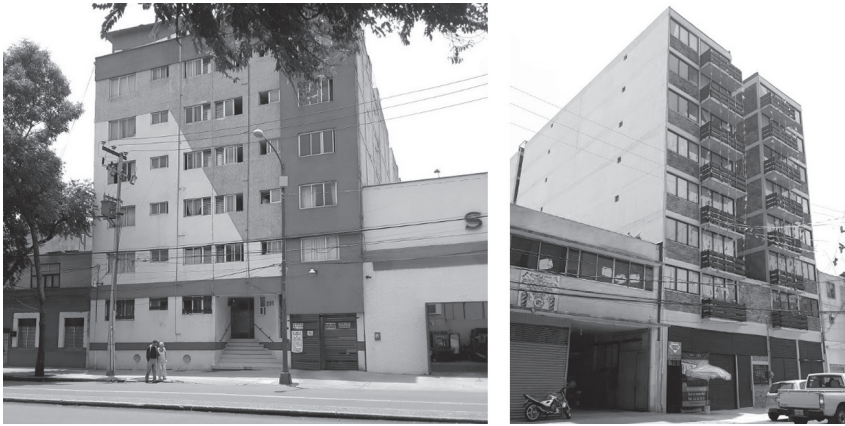
3. Edificaciones de tipo C y D. Fotografías: Archivo propio.
